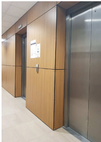
Ascenseurs modernes et tout à fait adaptés aux PMR (largeurs, présence d'une barre d'aide, interrupteurs ergonomiques)
