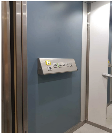
Ascenseurs modernes et tout à fait adaptés aux PMR (largeurs, présence d'une barre d'aide, interrupteurs ergonomiques)
