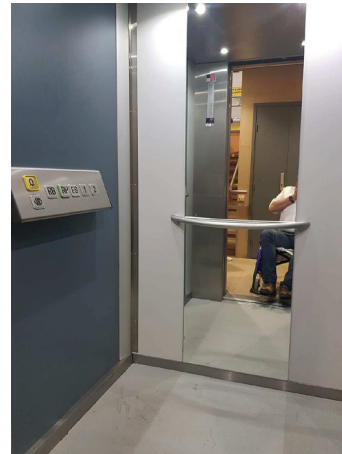
Ascenseurs modernes et tout à fait adaptés aux PMR (largeurs, présence d'une barre d'aide, interrupteurs ergonomiques)
